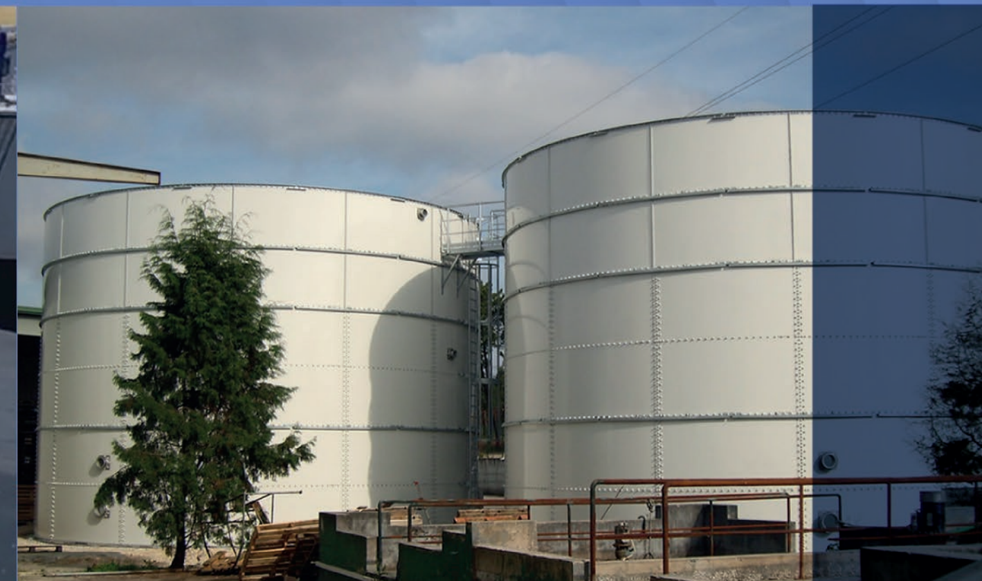
Tanques de aço parafusados revestimento epóxi
